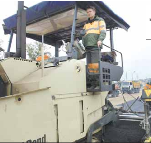
Добраўпарадкаванне вуліцы Будзённага. Брыгадзір Міхаіл РАКАУ і майстар укладчыка асфальтабетону Аляксандр САНТ.
