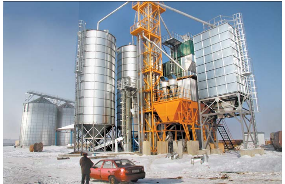
Новы комплекс для сушкі збожжа ў аддзяленні «Расна».
