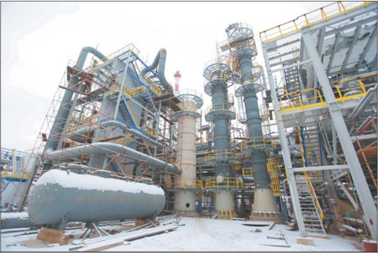
Установка получения серы методом Клауса.
