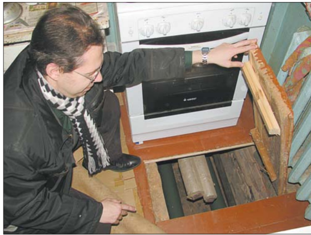
Такі люк у падлозе кухні Зінаіды ГАЎРЫЛАВАЙ павінен заставацца непрыйтым, каб у выпадку аварыі быў доступ да труб, што праходзяць пад падлогай кватэры.
