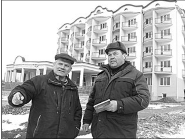
Галоўны інжынер ЖКГ Уладзімір ШАБОВІЧ і працаўнік ТАА «Сангранд» Дзмітрый ЖУРЫК на будаўніцтве новай гасцініцы.
