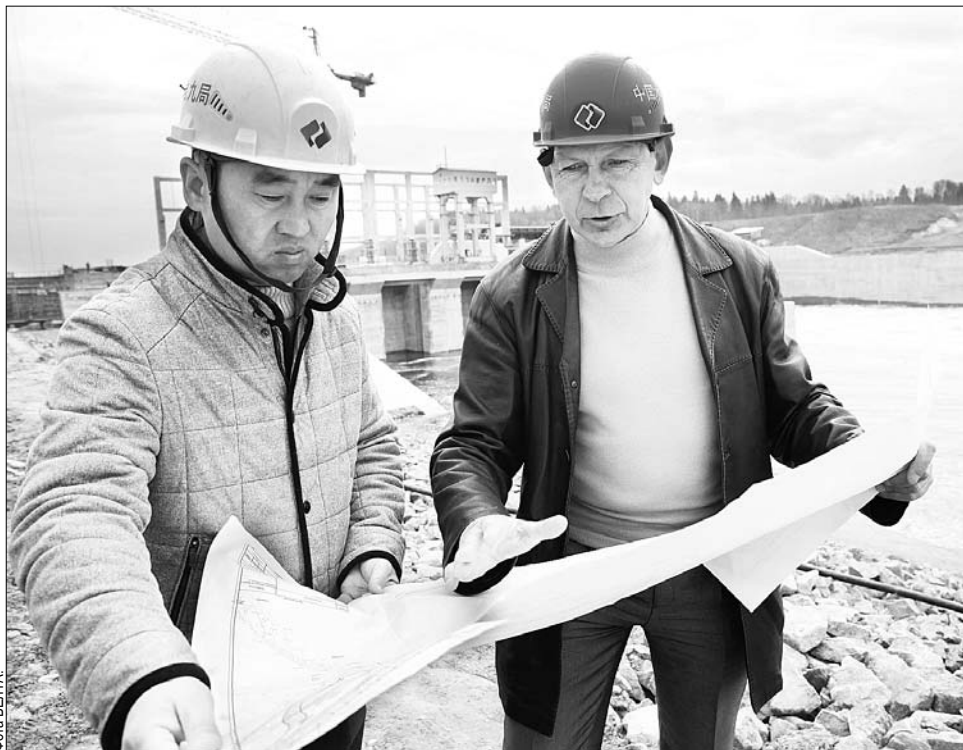
Ідзе будаўніцтва Віцебскай ГЭС.
