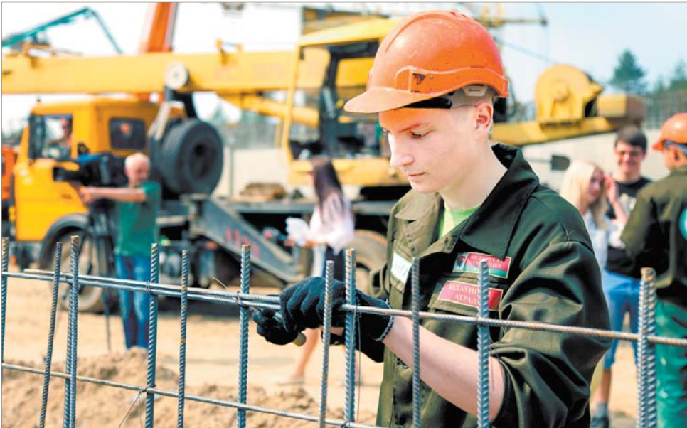
У беларуска-кітайскім індустрыяльным парку студэнты БНТУ займаюцца вязкай арматуры і заліўкай бетону.
