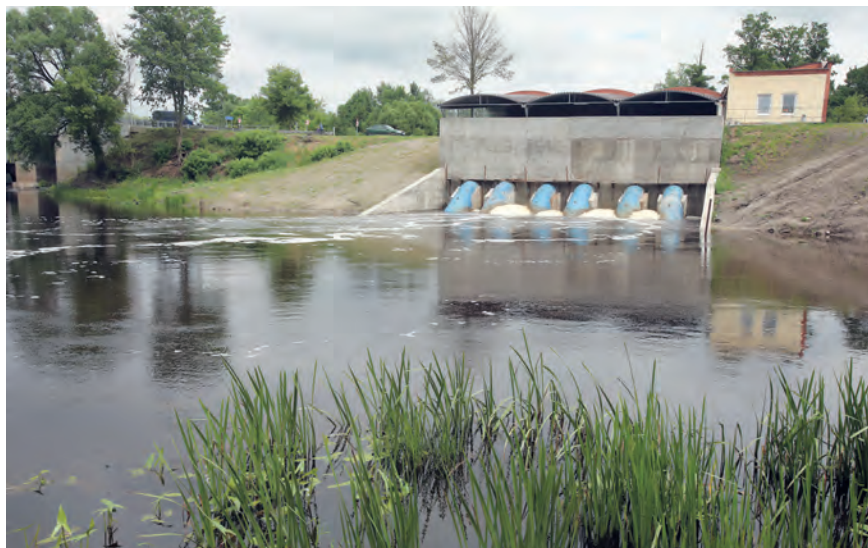
Малая гідраэлектрастанцыя на рацэ Іпуч у г. Добруш
