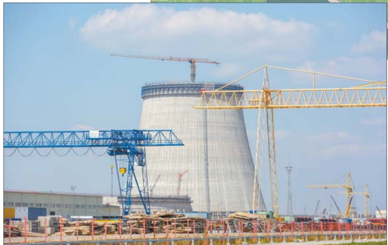
Строительная площадка Белорусской атомной электростанции летом 2015 г. фото БЕЛТА.
