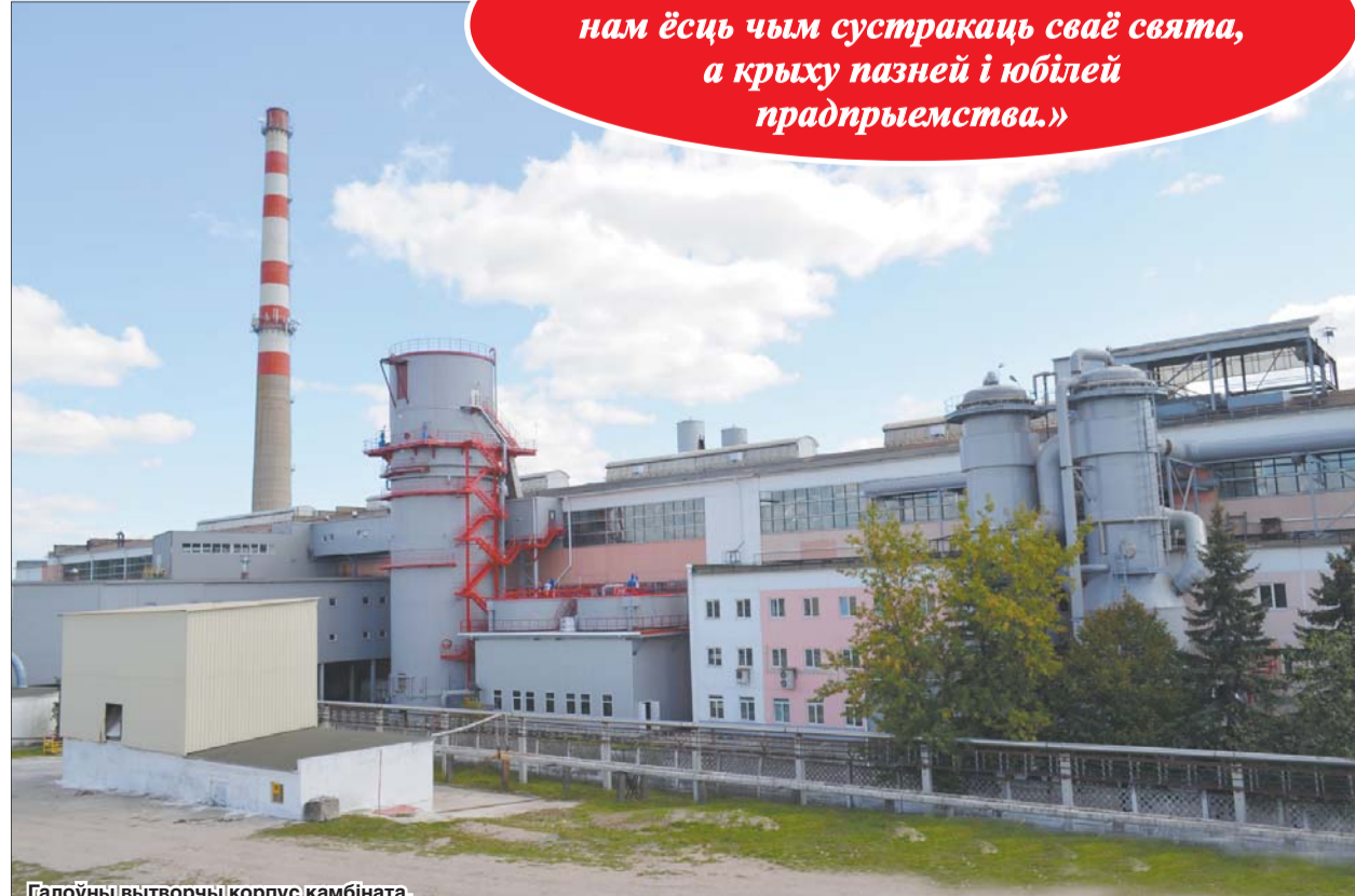
Галоўны вытворчы корпус камбіната.
