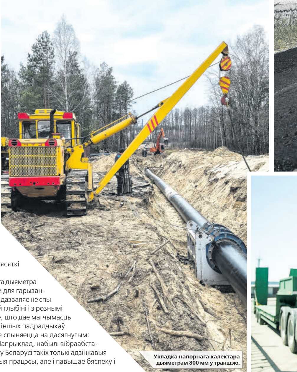
Укладка напорнага калектара дыяметрам 800 мм у траншею.
