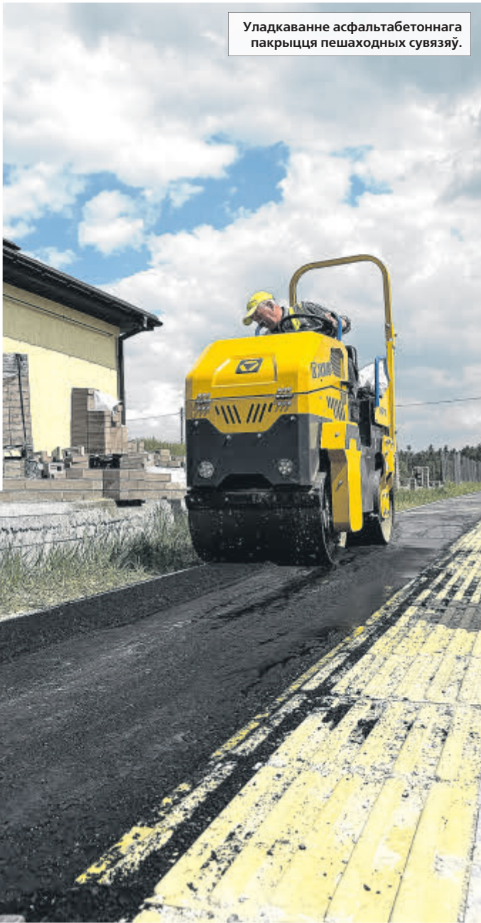
Уладкаванне асфальтабетоннага пакрыцця пешаходных сувязяў.
